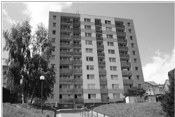
Panelový dům čp. 616
