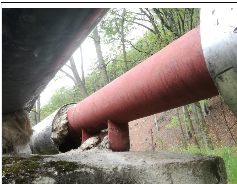
Starý teplovod ztráty
